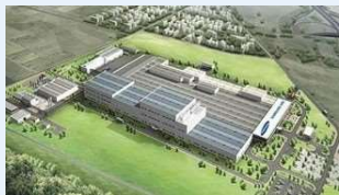
삼성SDI 헝가리 Dry Room
