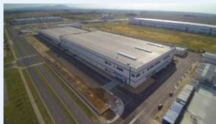
LG엔솔 폴란드 Dry Room
