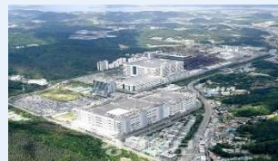
LGD 파주 Clean Room
