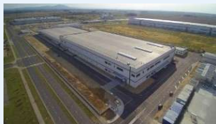
LG엔솔 폴란드 Dry Room
