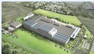
삼성SDI 헝가리 Dry Room
